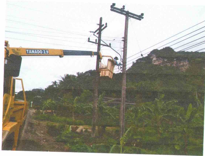
ภาพถ่ายดำเนินการเสร็จ
